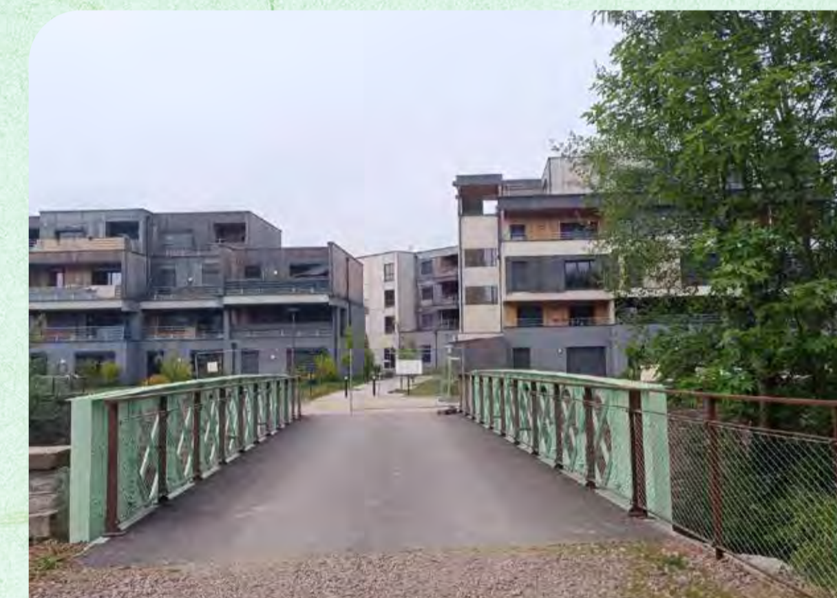
Passerelle Nord APRÈS
