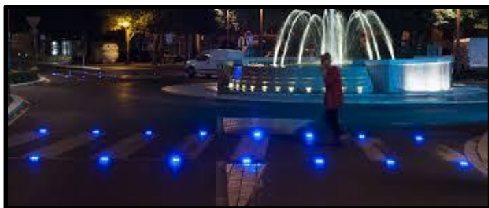
Figure 1 - Exemple de LED encastrés dans la chaussée
