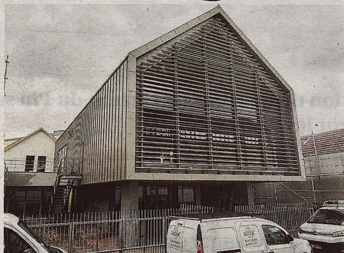
Au centre de l'ancienne friche Bragard, la Filature a été conçue pour épouser la forme des sheds, ces toitures en dents de scie propres aux usines de l'époque. Photo Grégoire Hallinger
