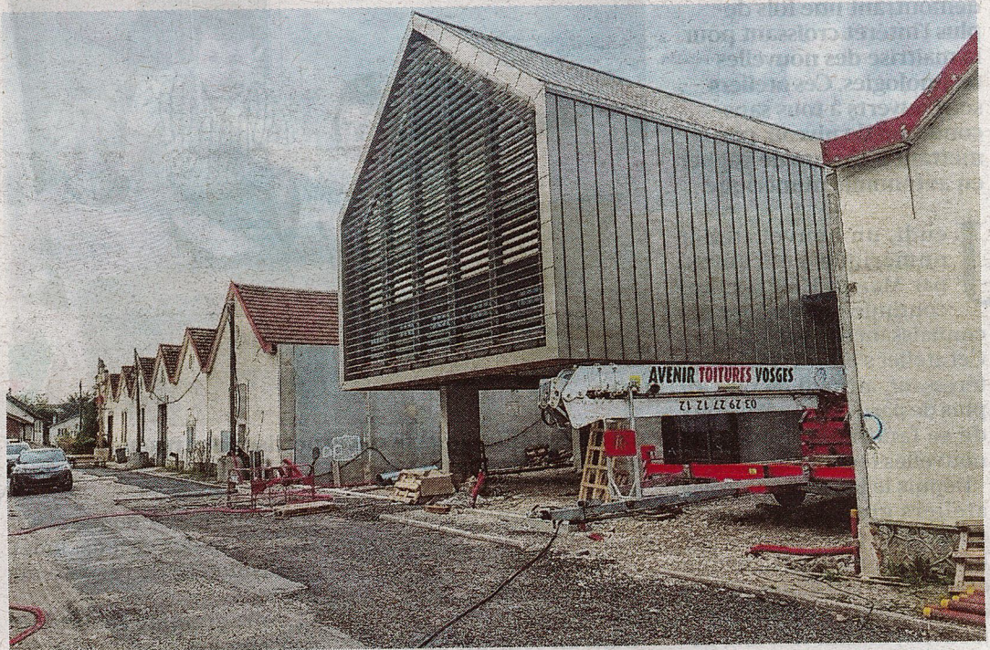
Le nouveau centre de stockage et de consultation des archives, La Filature, est construit dans les anciennes usines textiles Bragard, Photo Ph.N.
