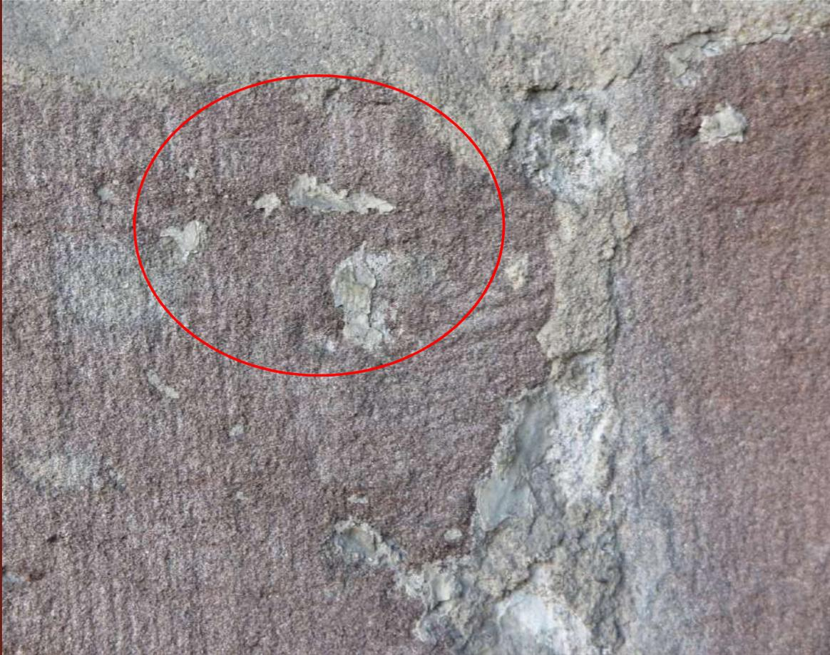
Traces d'enduit ancien sur parement entre les colonnes hautes
