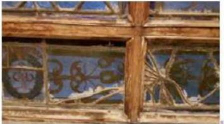
Développement des traces et humidité, coloriments de maillages remplis de plomb
