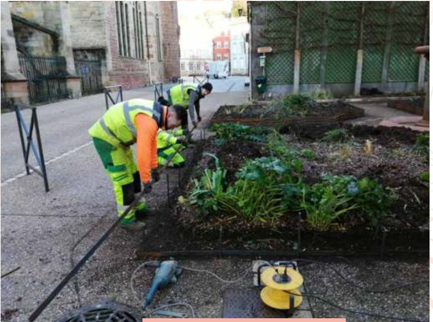
Aménagement d'une bordure de massifs à l'aide de facines en lames acier (chantier printemps 2022)
