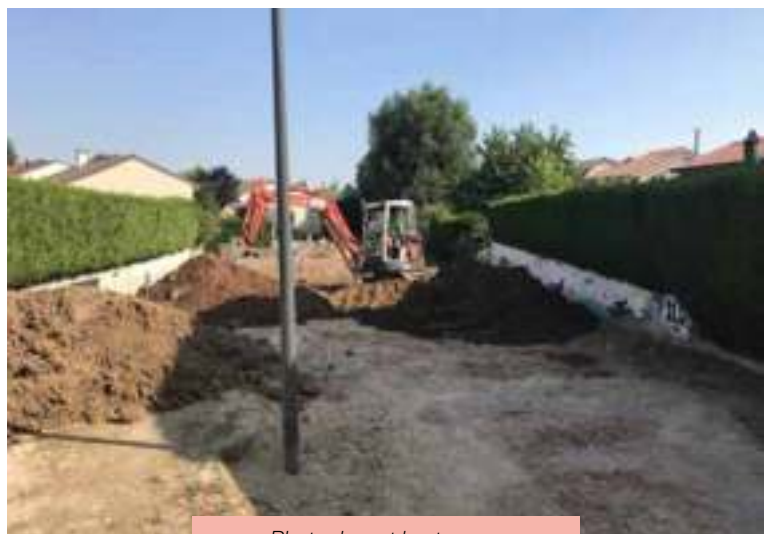
Photo durant les travaux
