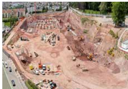
Début des travaux - 2014
