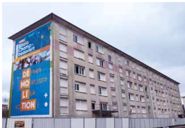
Deux bâtiments du bailleur social Épinal Habitat vont être démolis dans le quartier de Bitola
