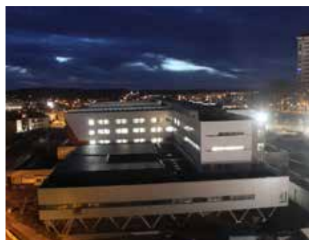
Installation dans les locaux - mars 2021
