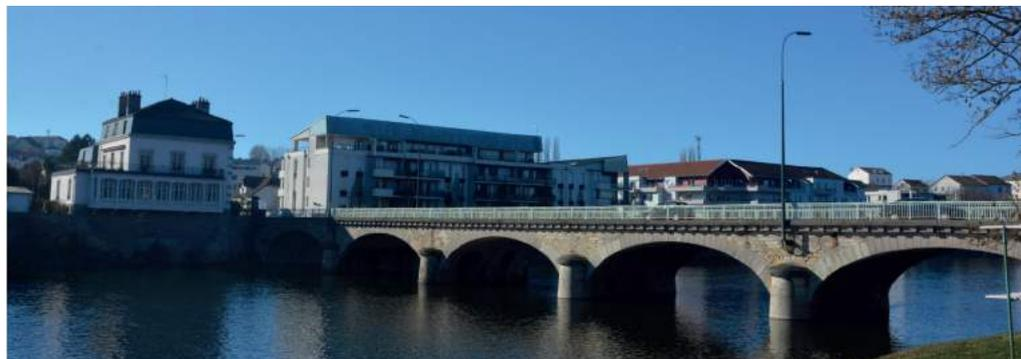
Ce chantier d'un montant estimatif de 350 616 € TTC confié à l'Entreprise Bonini est porté par la Communauté d'Agglomération d'Epinal et les objectifs seront la rénovation complète de l'étanchéité du tablier, des piles, des corniches, des trottoirs, le rejointoiement des maçonneries ou encore le remplacement des garde-corps.
