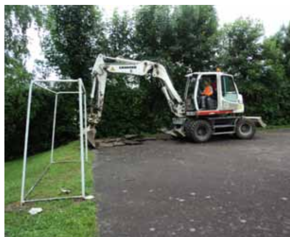
Les travaux de construction du terrain multisports ont commencé le 28 mai dernier
