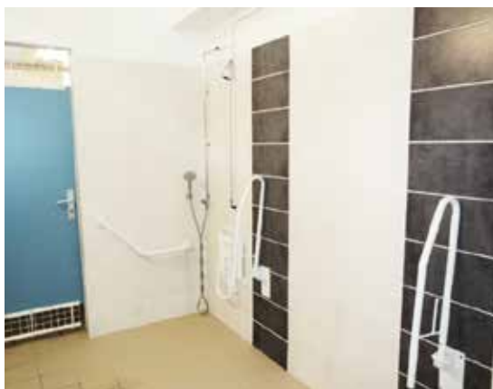
La piscine olympique a été mise en accessibilité en 2017 pour un montant de 75 000 euros et offre désormais un système mobile de mise à l'eau pouvant être installé à différents endroits du bassin. Les douches, les vestiaires, les sanitaires et le pédiluve sont également adaptés.
