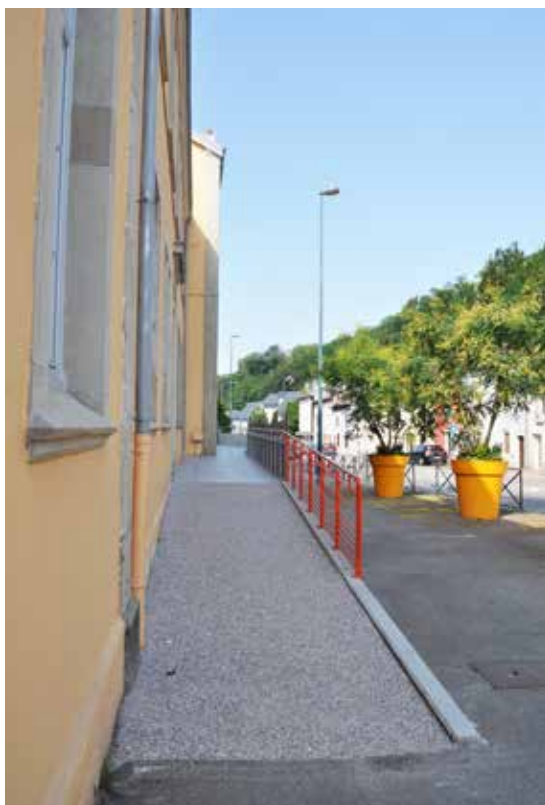
À l'école d'Ambrail, d'importants travaux ont été réalisés avec l'ajout d'une rampe d'accès en 2017 et la mise en accessibilité des sanitaires en 2018.
