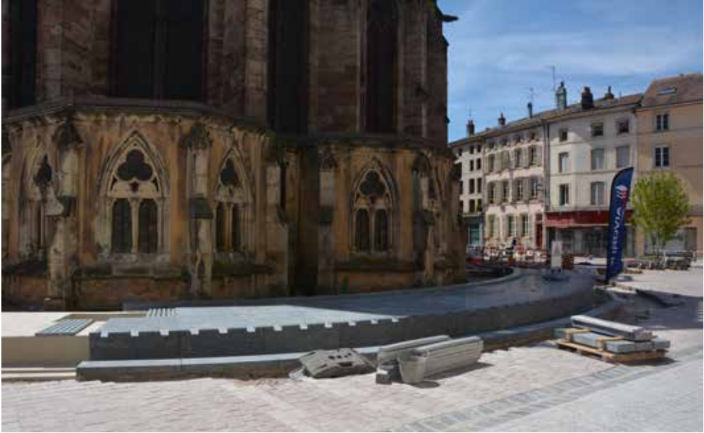
La nouvelle fontaine en chute d'eau ceinture la sacristie de la basilique
