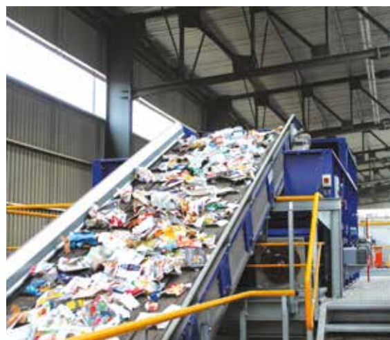
Centre de recyclage des déchets ménagers de la Maix à Chavelot © Evodia Vosges
