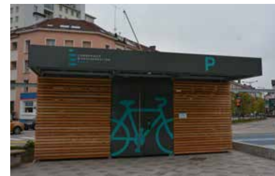
Un garage à vélo sécurisé a été édifié sur le parvis de la gare par la Communauté d'agglomération d'Épinal.
